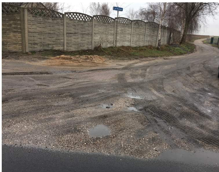
Fot. 1 Droga gminna na wlocie w drogę wojewódzką nr 552 w km 14+480
