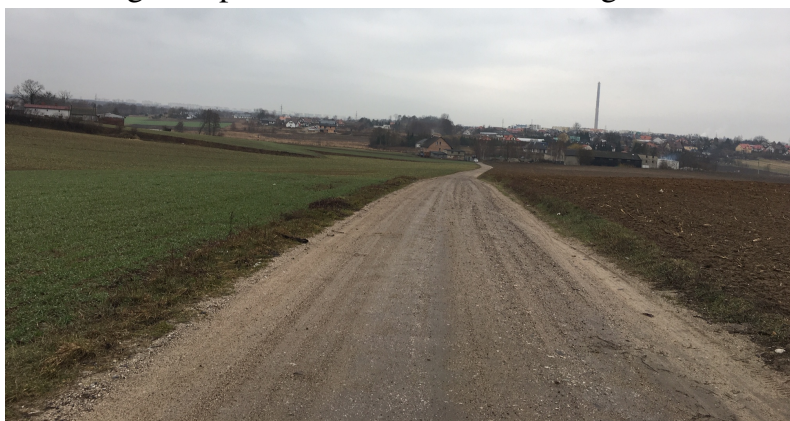
Fot. 1 Widok drogi gminnej – ul. Przydatki
