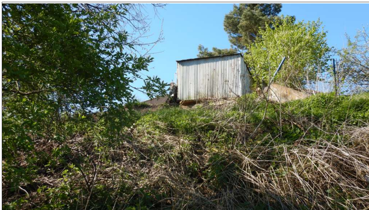
Skarpa główna osuwiska z blaszanym budynkiem gospodarczym tuż przy górnej krawędzi (maj, 2023)
