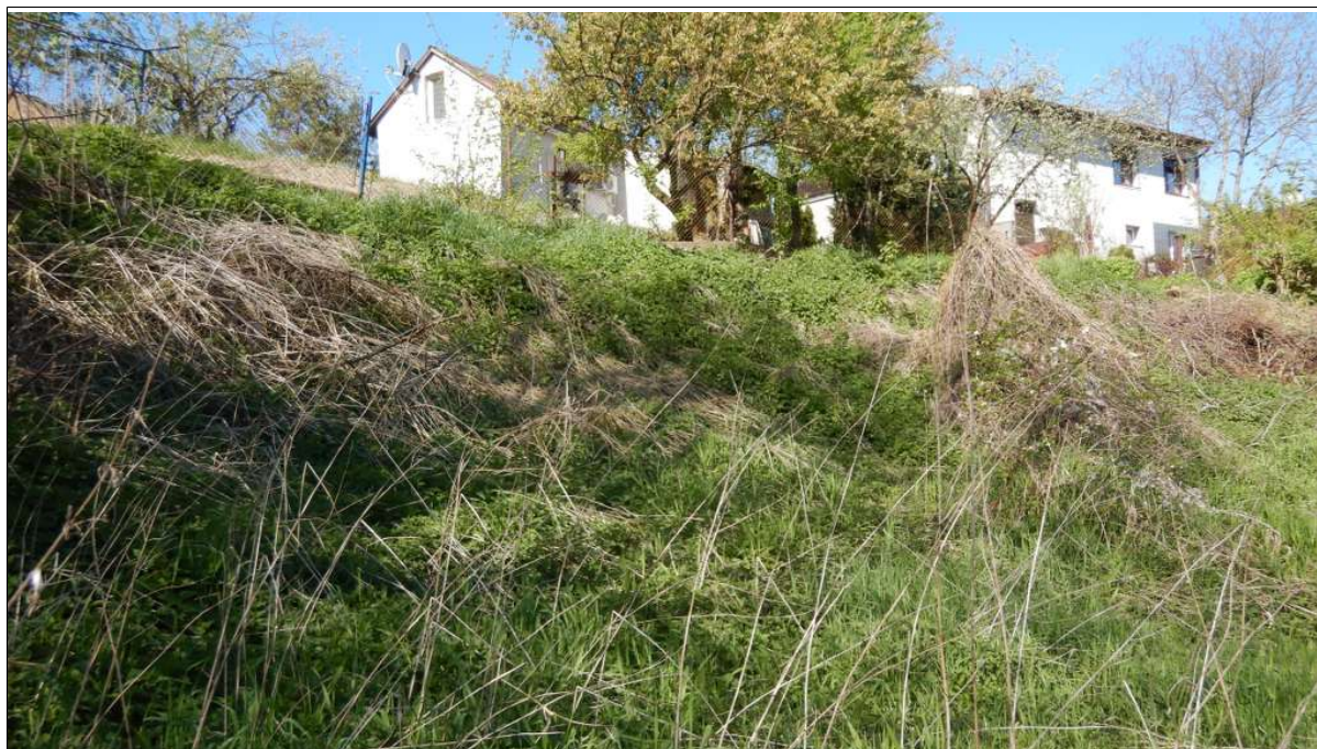
Skarpa główna osuwiska z budynkami w pobliżu górnej krawędzi (maj, 2023)
