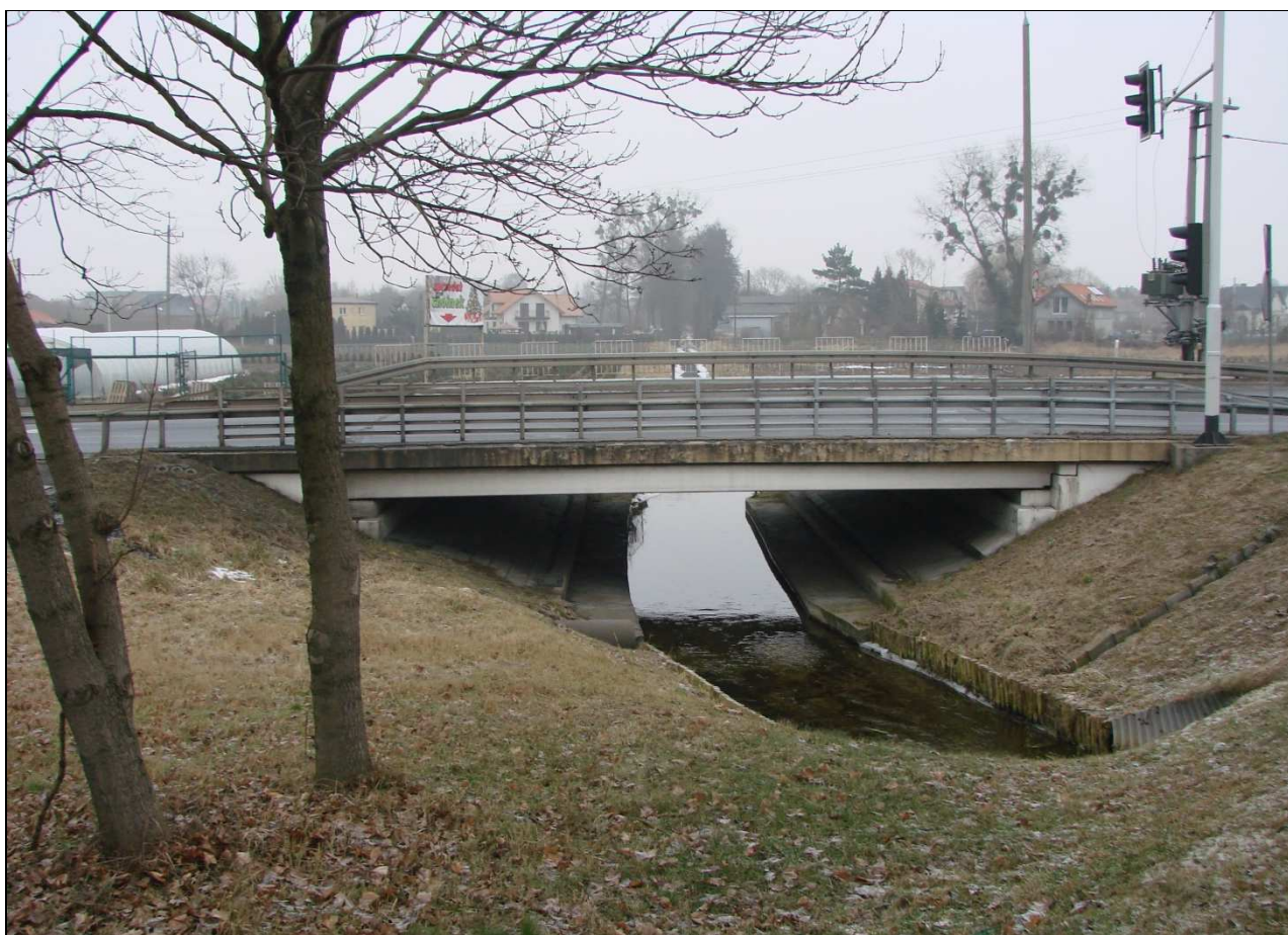
Fotografia 3-4 Most przebiegający w ciągu drogi wojewódzkiej nr 552 w km 13+587 nad ciekiem Struga Toruńska. W tle krajobraz wiejski oraz typowa zabudowa jednorodzinna, 01.2017
