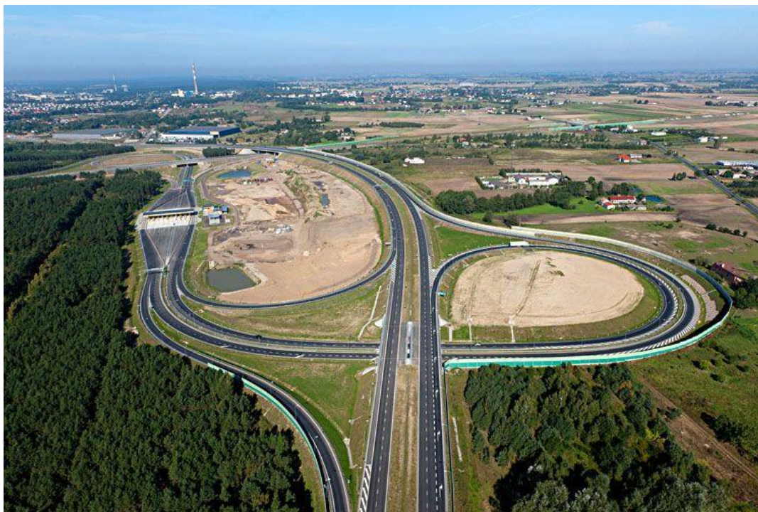
Zdjęcie 3. Węzeł autostrady A1 – „Lubicz”
