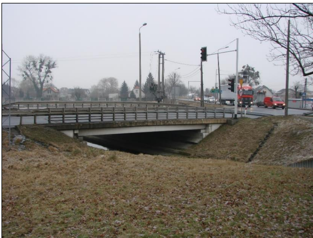
Fotografia 2-2 Widok mostu nad Strugą Toruńską
