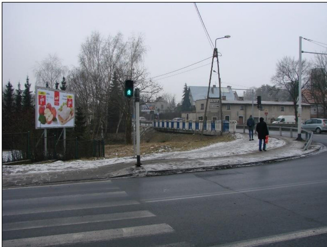
Fotografia 2-3 Krajobraz rejonu inwestycji - infrastruktura i pojedyncze zadrzewienia przy Strudze Toruńskiej
