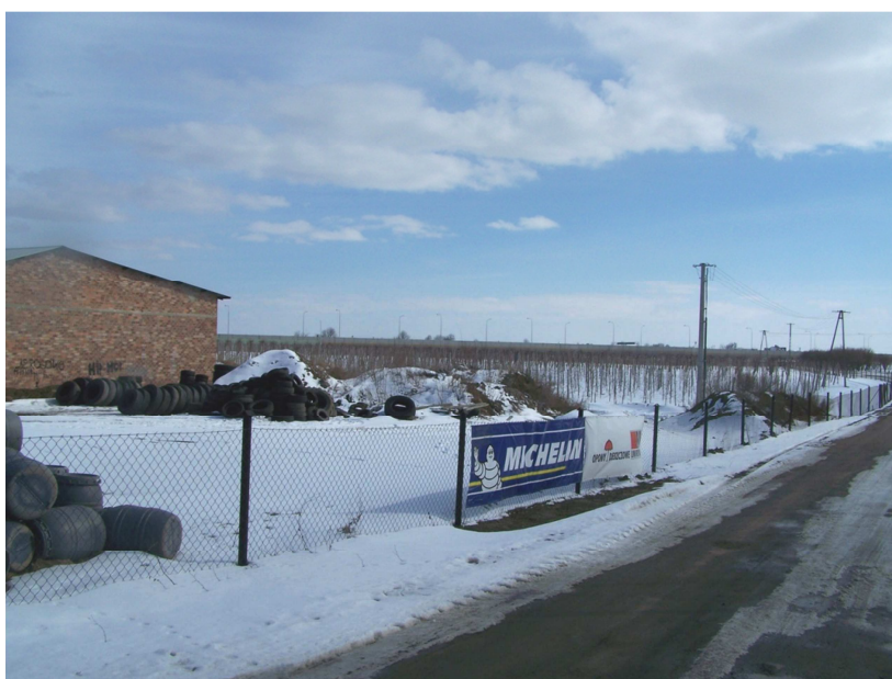
Fot. 4 teren lokalizacji nowej hali
