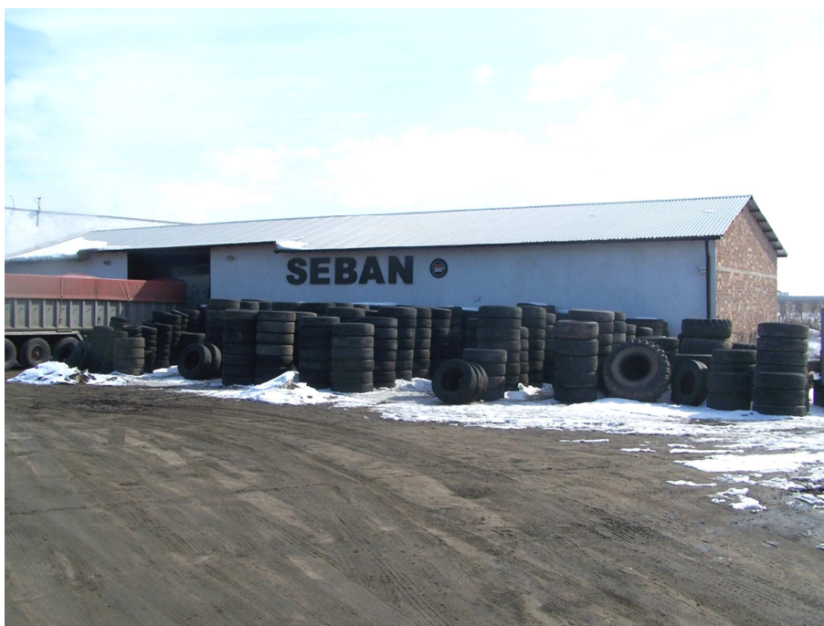
Fot. 2 budynek obecnej hali serwisu opon (docelowo przewidziany na magazyn opon)
