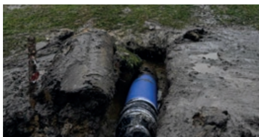
Dla poprawy ciśnienia wody w kranach i zapewnienia ciągłości dostaw zbudowano nową magistralę wodną wraz z przewiertem pod dnem Drwęcy
