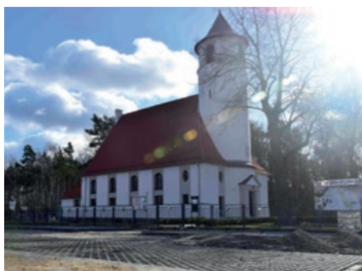
Budowa skweru w centrum wsi wraz z parkingiem pod kościołem
