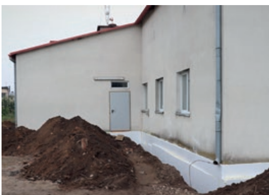
Nowe szambo i ocieplenie fundamentów świetlicy i remizy
