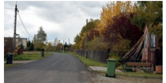
Budowa ul. Dolina Drwęcy wraz z remontem drogi do Józefowa
