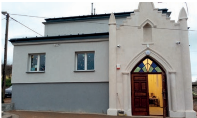
Obiekt świetlicy przy ul. Bocznej został wyremontowany, a przyległa doń dawna kaplica po gruntownej przebudowie pełni funkcję dodatkowej sali i świetlicy
