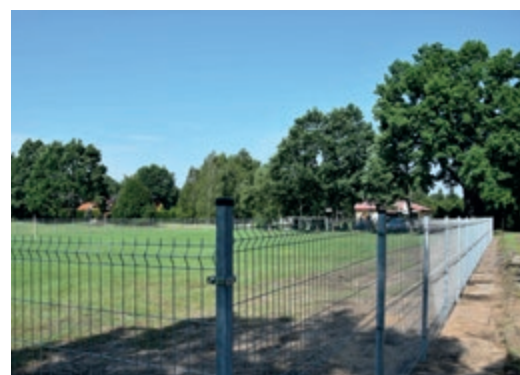
Ogrodzenie i oświetlenie boiska, murawa i zagospodarowanie
