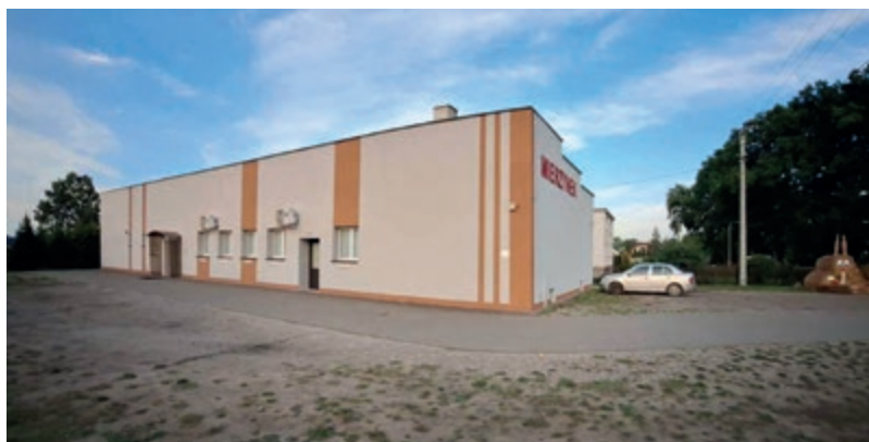
Gruntowna modernizacja świetlicy wiejskiej na zewnątrz
