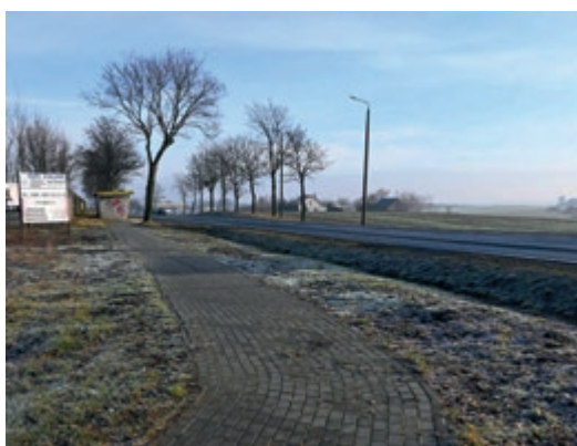
Budowa chodnika od przystanku przy DK15
