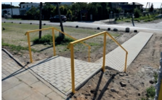
Budowa schodów i chodnika z przystanku do placu „na dolku”
