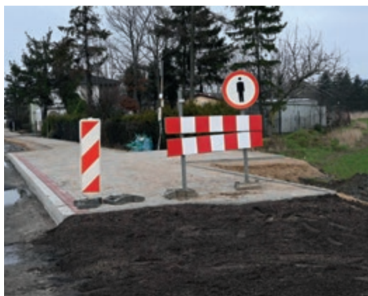
Wybudowano chodnik i przystanek przy DK 15 od strony wsi. Przed nami drugi etap czyli budowa chodnika po drugiej stronie drogi krajowej wraz z przejściem dla pieszych i peronem przystankowym w stronę Torunia.
