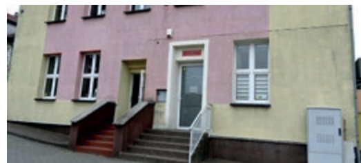
Adaptacja pomieszczeń szkoły na poradnię pedagogiczno-psychologiczną
