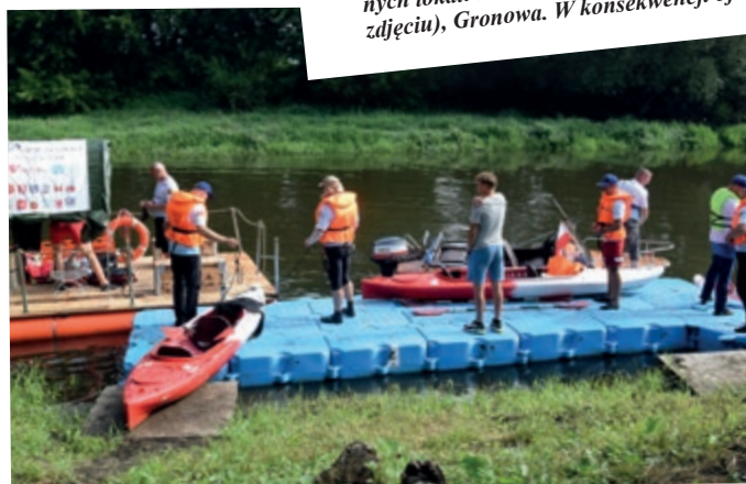
W celu poprawy warunków do uprawiania turystyki wodnej zakupiono i zainstalowano pomosty pływające na Drwęcy w Lubiczu Dolnym, w Złotorii, nad jeziorem w Józefowie. Wybudowano również pomost do przenoski przy tamie Toruńskich Wodociągów
