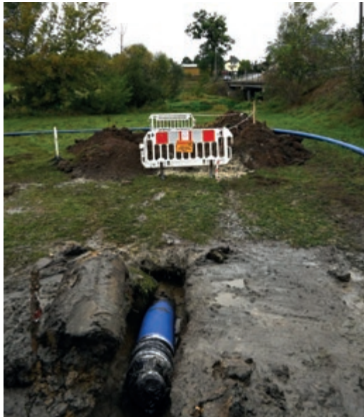
Pod dnem Drwęcy pomiędzy Młyncami wybudowano metodą przewiertu nowe połączenie magistrali wodociągowej, co zapewni pewność dostaw i poprawi ciśnienie wody
