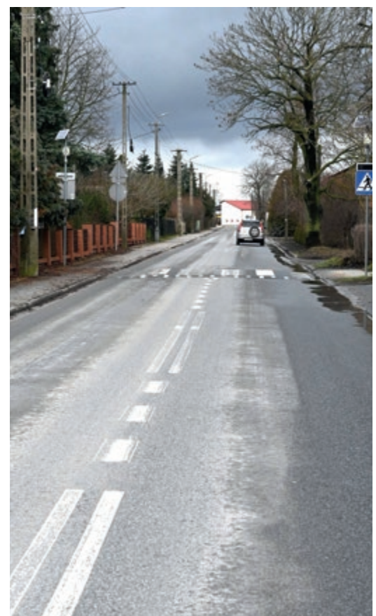
Remont drogi do Turzna przez centrum wsi
