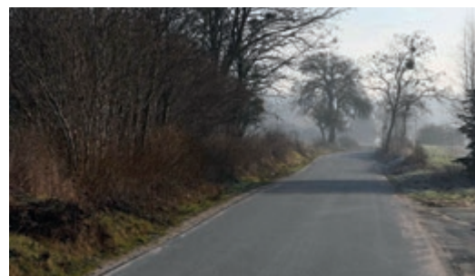
Przebudowa drogi gminnej 742C
