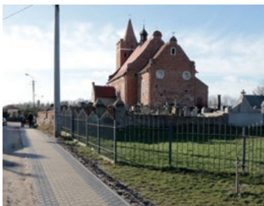
Wzdłuż muru kościoła zbudowano nowy chodnik
