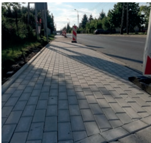
Remont chodnika na ul. Dworcowej
