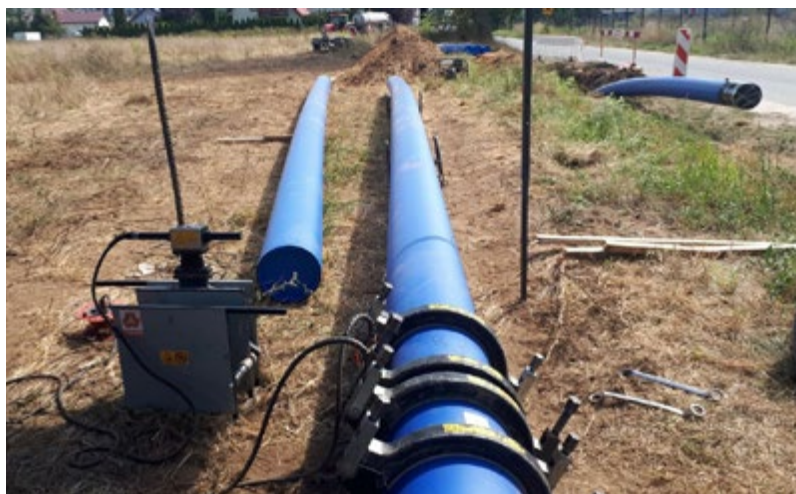
Dotychczasowy wodociąg zasilający w wodę mieszkańców Lubicza Górnego, Krobi i Mierzynka posiadał zbyt małą średnicę, obecnie jest dużo większy i wykonany w nowej technologii. Fot. (LS)
