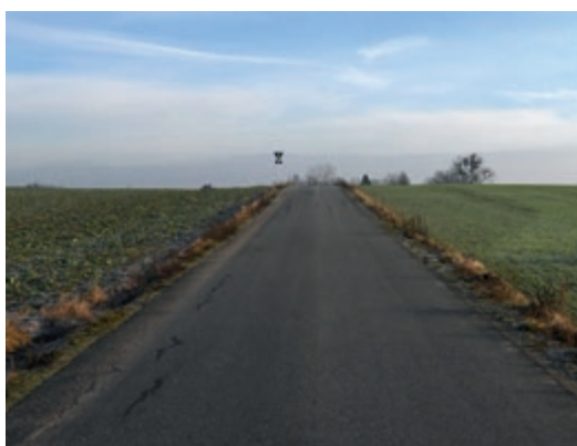
Przebudowa drogi gminnej 737C
