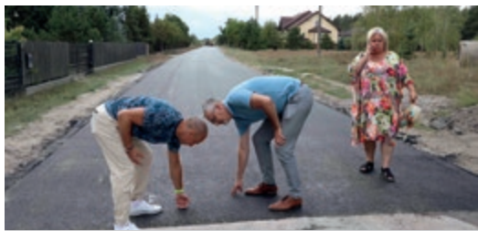
Zmodernizowano nawierzchnię ul. Rogówskiej
