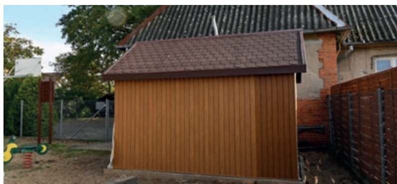
Za budynkiem świetlicy powstał magazyn na sprzęt sołecki
