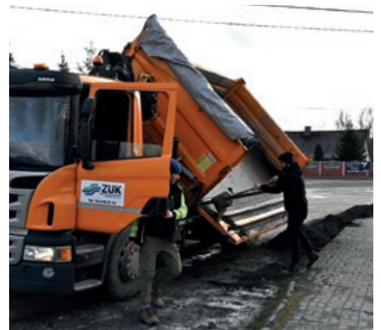
Dla potrzeb uruchomienia nowej linii MZK nr 123 przygotowano tymczasowy przystanek. W tym miejscu zostanie wybudowana nowoczesna zatoczka w kształcie „leżki” dla kursów w obydwie strony
