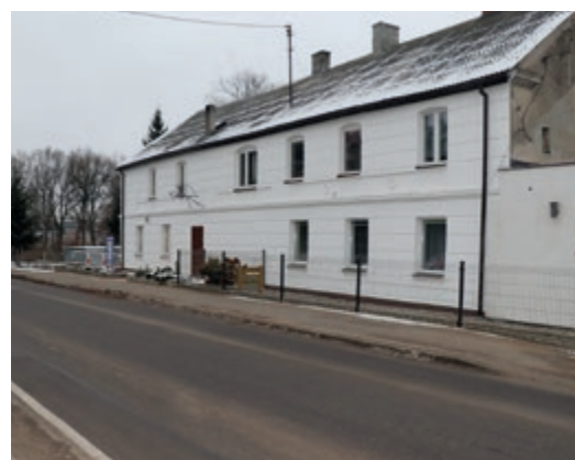
Remont świetlicy na zewnątrz
