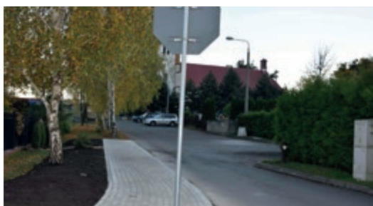
Budowa chodnika i modernizacja skrzyżowania przy kościele
