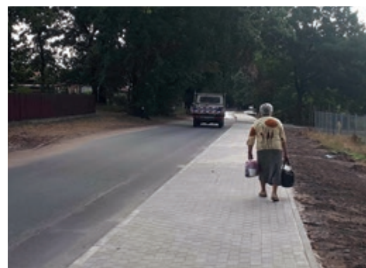
Wybudowano chodnik wzdłuż wsi z dodatkowymi przejściami dla pieszych
