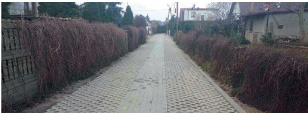
Odnogi ul. Leśnej i ul. Lipowej zbudowano w technologii uwzględniającej dużą ilość wód opadowych
