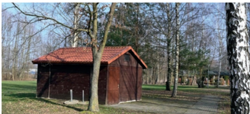
Zgromadzony sprzęt świetlicowy, sportowy, rekreacyjny wymagał zmagazynowania i zabezpieczenia. Służy temu zaplecze techniczne
