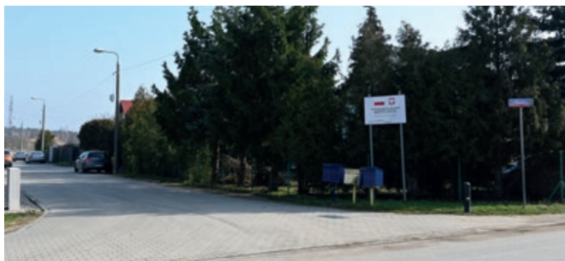
Powstała nawierzchnia z kostki na ul. Poprzecznej
