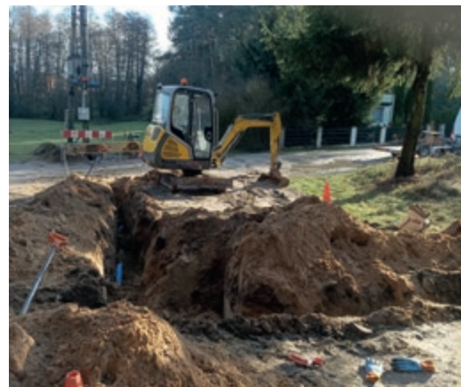
Zamontowano nowe lampy uliczne na ul. Golubskiej, Gronowskiej, Jesionowej, na przystankach. Na zdjęciu budowa jednego z przyłączy
