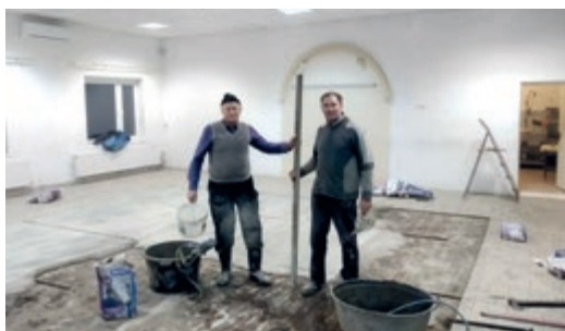
Remont i doposażenie świątynicy wewnątrz
