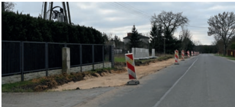
Dokończenie budowy ścieżki rowerowej przez Nową Wieś leży na sercu wszystkim mieszkańcom. Widać już realnie finał inwestycji
