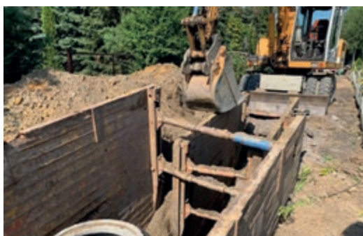
Wybudowano sieć kanalizacyjną w ulicach: Nowej, Pomorskiej, Flisackiej, Szkolnej, Pocztowej, Sportowej, Wodniackiej, Sosnowej, Piaskowej
