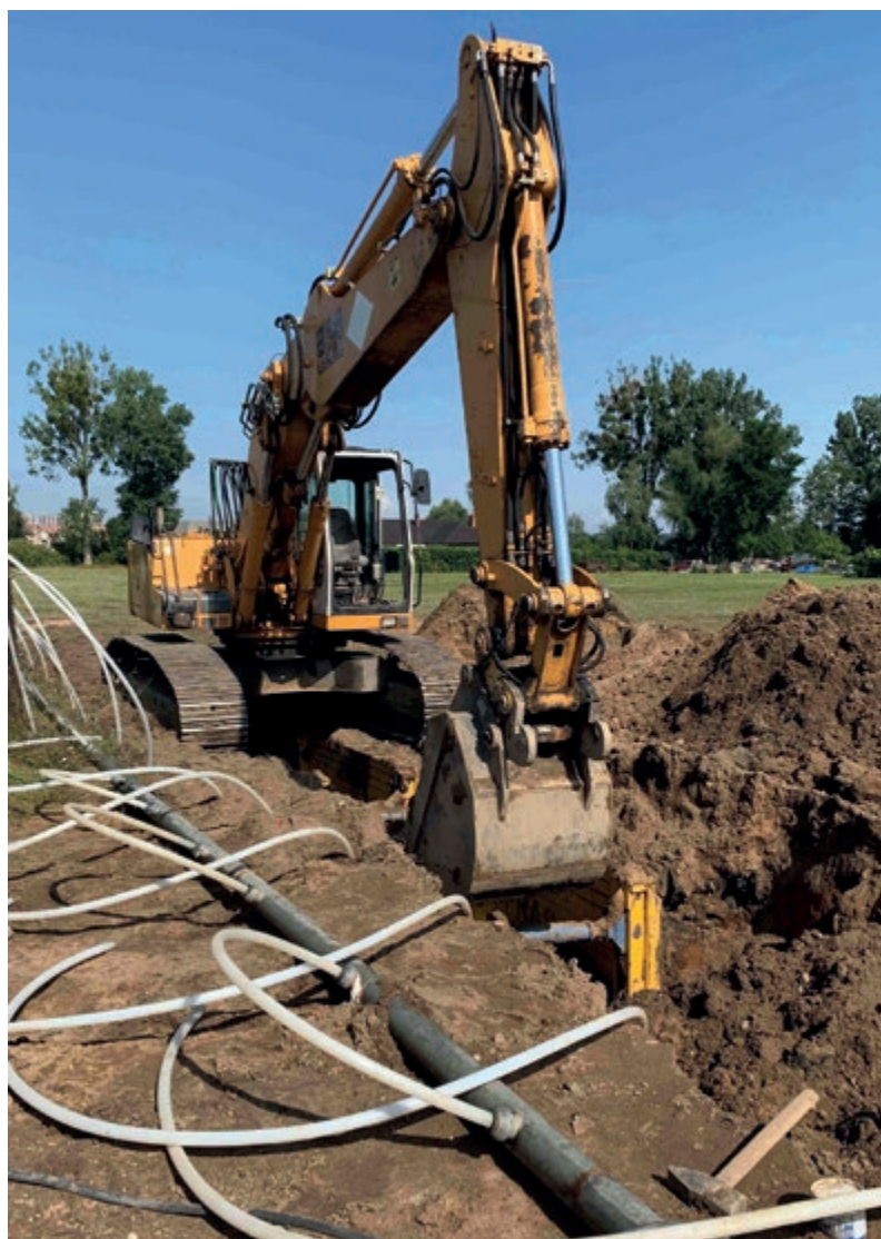
Rozbudowa sieci kanalizacyjnej za 13 mln zł w ulicach: Okrągłej, Olszynowej, Olimpijskiej, Pod Dębami, Cisowej, Osikowej, Osiedlowej, Żymiej, Makowej, Poprzecznej, Długiej, Cytrynowej, Krótkiej, Jaśminowej, Oliwkowej, Leszczynowej i Malinowej
