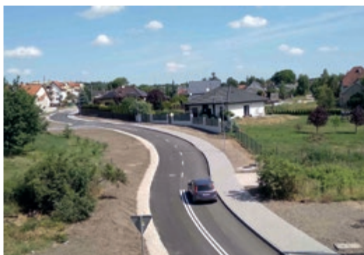
Ul. Narcyzowa, jedna z głównych ulic Lubicza Dolnego po modernizacji
