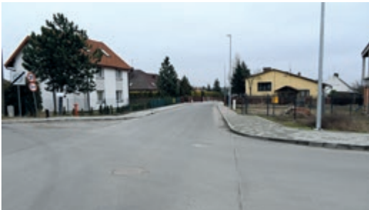
Kompleksowa modernizacja ul. Toruńskiej
