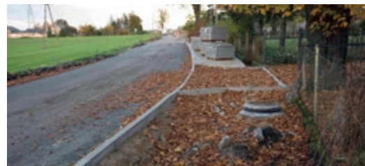
Przebudowa chodnika wraz ze studzienkami w Kolonii Papowskiej w ramach modernizacji drogi powiatowej
