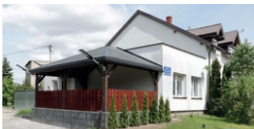
Zbudowano wiatę nad tarasem przy świetlicy, wyremontowano nawierzchnie, schody, odmalowano pomieszczenia wewnątrz
