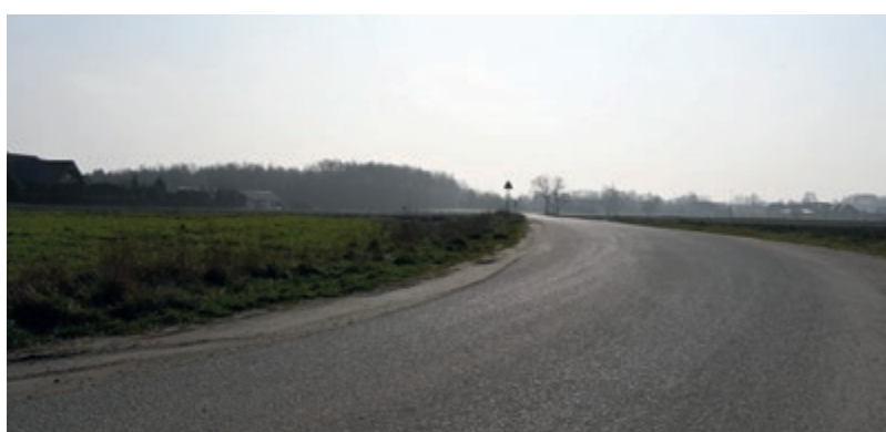
Wybudowano przedłużenie ul. Granicznej i Wiejskiej
