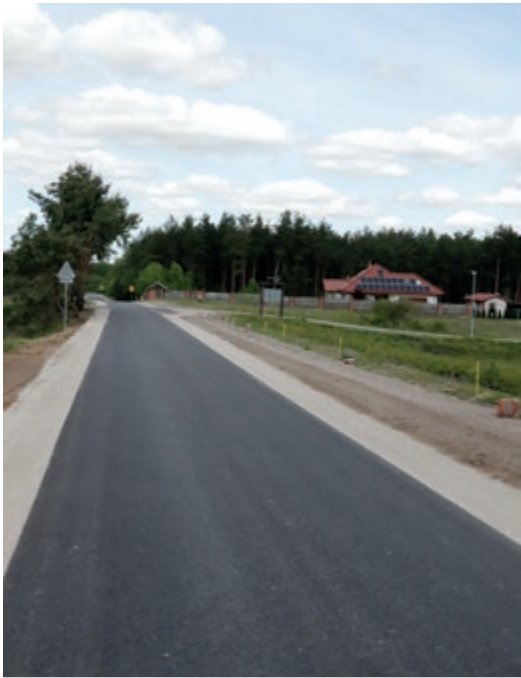
Budowa ulicy Żwirowej wraz z pobocznymi
