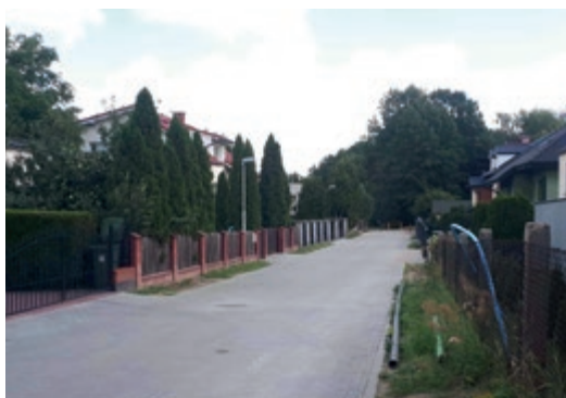
Budowa wodociągu i nawierzchni w ulicach Wiśniowej i Malinowej
