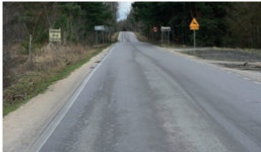
Droga do Mierzynka zyskała nową nawierzchnię asfaltową
