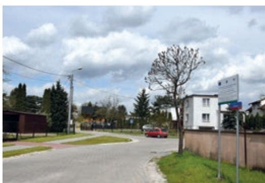
Fragment ul. Szkolnej już zmodernizowany, a przed nami przebudowa pozostałego odcinka w okolicach CAS
