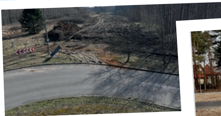
Droga do Małgorzatowa już się buduje, o czym szerzej piszemy na str. 5
