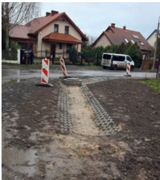
Odwodnienie ul. Nad Strugą i Wiatraczną
