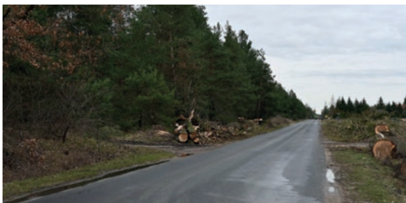
Rozpoczęła się budowa ścieżki rowerowo-pieszkiej z Krobi do Młynca Drugiego
