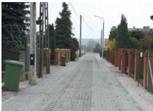
Nowa nawierzchnia ul. Spokojnej
