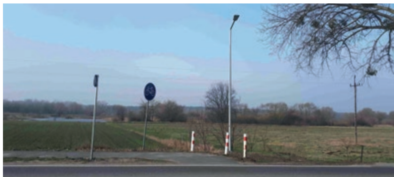
Zamontowano dziewięć lamp solarnych i pięć sieciowych
