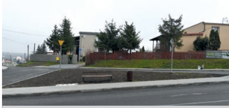
Za nami pierwszy etap rewitalizacji ulicy Lipnowskiej. Powstały nowe chodniki, zjazdy, trawniki, jezdnia
