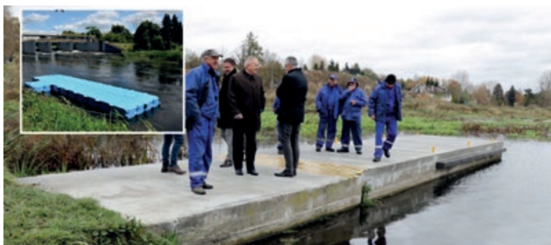
Splywy kajakowe przepływające Drwęcą muszą pokonać tamę Toruńskich Wodociągów. Dla ułatwienia tzw. przenoski powstało specjalne nabrzeże z pochylnią oraz zakupiono nowy pomost pływający
