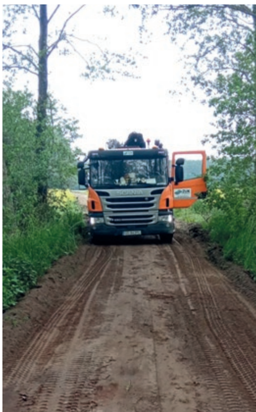
Wykonano szlak spacerowy Kopanino wraz z modernizacją przepustu
