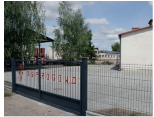
Nowy parking przy świetlicy i ogrodzenie wokół
