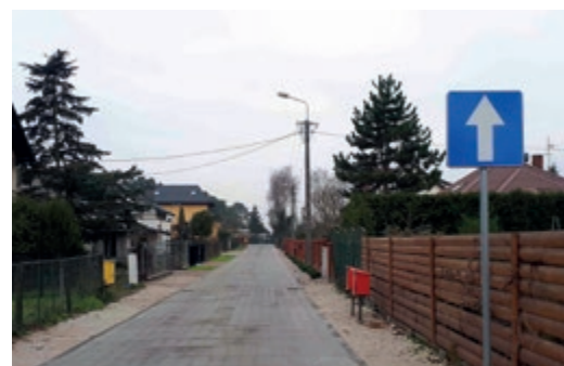
Ul. Ciecchońska zbudowana na nowo z kostki chłonej wodę
