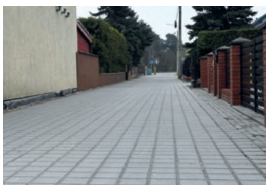
Zupełnie nowa nawierzchnia ul. Nieszawskiej
