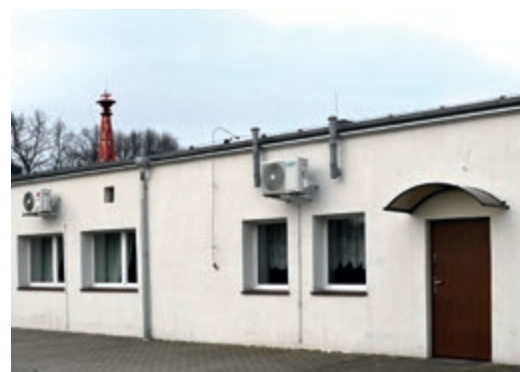
Nowa nawierzchnia placu za świetlicą, nowe drzwi wejściowe z daszkami ochronnymi
