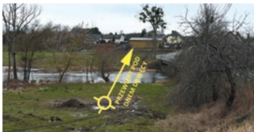
Pod dnem Drwęcy wybudowane zupełnie nowe połączenie magistrali wodociągowej, co zapewni pewność dostaw i poprawi ciśnienie wody
