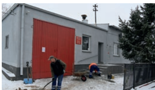
Remont remizy na zewnątrz, zakup nowego pieca
