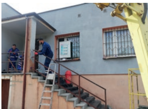
Remont świetlicy na zewnątrz
