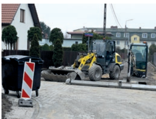
Modernizacja na ul. Rekreacyjnej
