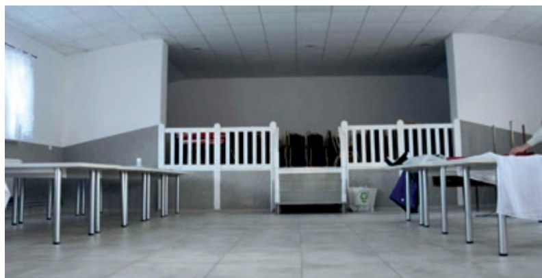
Remont i przebudowa świetlicy wewnątrz wraz z niezbędnym wyposażeniem
