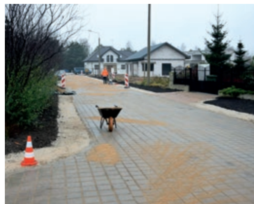
Przebudowa ulicy Obi Wana Kenobiego
