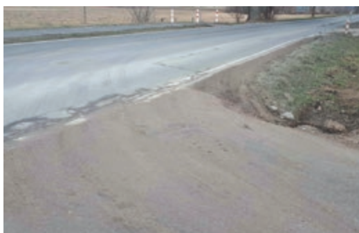
Zjazd z drogi wojewódzkiej na ul. Piastów oraz budowa odcinków ul. Liliowej i Różanej
