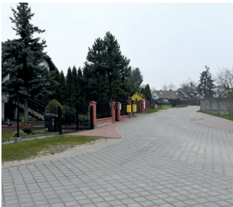
Budowa ul. Flisackiej
