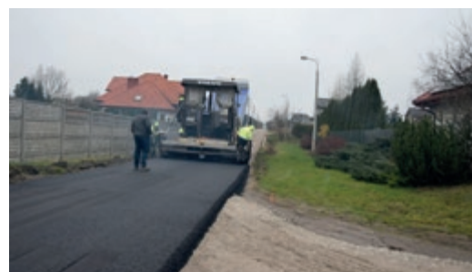
Asfaltowanie wraz z odwodnieniem ul. Osiedlowej
