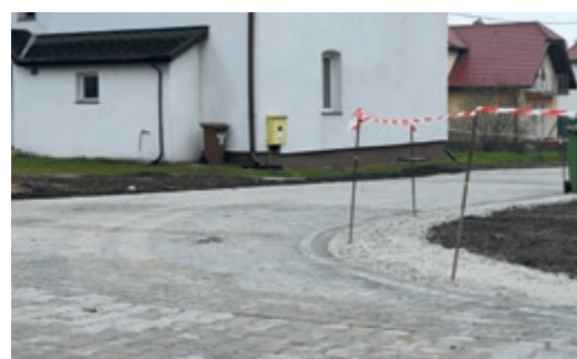
Przebudowa ul. Cichej
