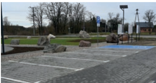
Wybudowano nowy parking przy świetlicy wraz z solarnym oświetleniem
