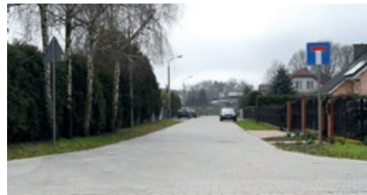
Dojazd do posesji na ul. Morelowej zyskał nową nawierzchnię z kostki
