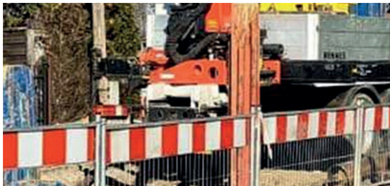
Wybudowano tłoczną sieć kanalizacyjną wzdłuż ul. Dolina Drwęcy
