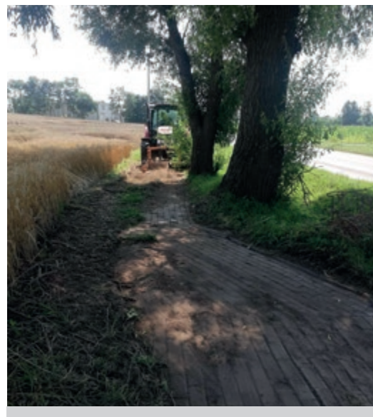
Prace interwencyjne poprawiającej stan chodnika wzdłuż drogi wojewódzkiej 552
