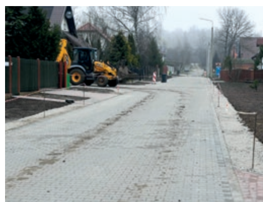
Ul. Źródłana zyskała nową nawierzchnię z kostki
