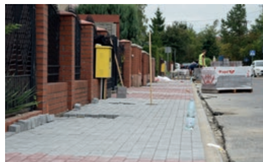
Na ul. Kamiennej zbudowano nowe chodniki
