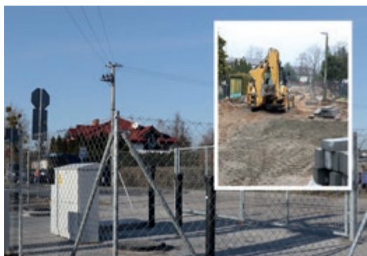
Budowa kanalizacji w ulicach Wiśniowej i Malinowej z kanałem tłocznym do ul. Nostalgicznej i przepompownią ścieków
