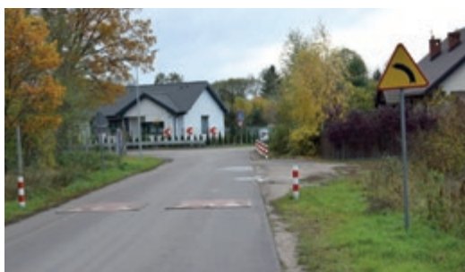
Dla poprawy bezpieczeństwa dokonano zmian w organizacji ruchu przez wieś, zamontowano przy świetlicy światła ostrzegawcze, przebudowano łuk drogi, zainstalowano progi zwalniające
