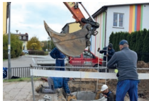
Rozbudowa sieci kanalizacyjnej w Lubiczu Dolnym na ulicach: Magnoliowej, Kolejowej, Ogrodowej, Leśnej, Klonowej, Toruńskiej, Jesionowej, Kasztanowej, Cichej, Źródlanej, Przemysłowej, Rekreacyjnej, Szmaragdowej, Podgórznej, Miodowej, Ceramicznej, Spokojnej, Strumykowej i Dworcowej
