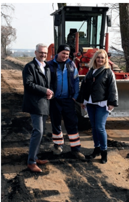
Rozpoczęła się długooczekiwana budowa drogi gminnej nr 749C. Koszt przedsięwzięcia to ponad 1 mln zł
