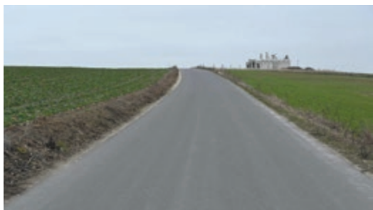
Nowa nawierzchnia na ul. Przydatki
