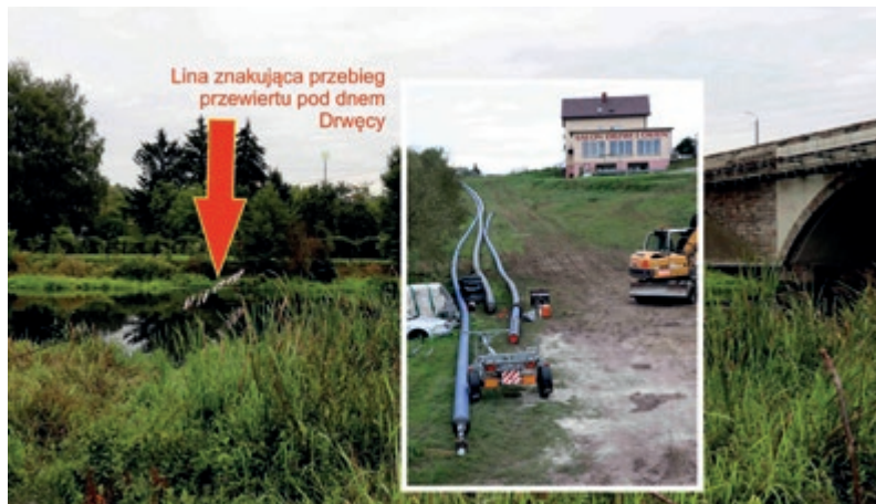
W ramach modernizacji sieci wodociągowej, która ma poprawić ciśnienie wody, wybudowano pod dnem Drwęcy nowe przyłącze dla Lubicza Górnego, Krobi i Mierzynka
