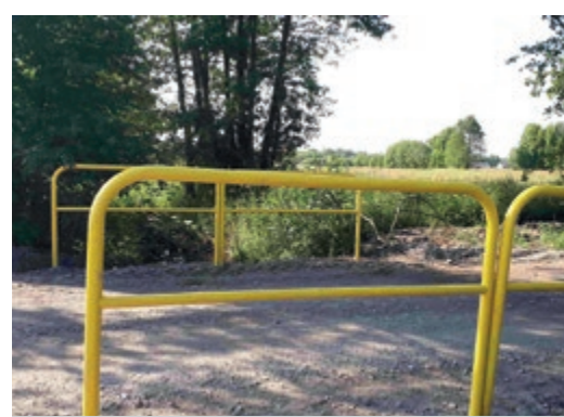
Przebudowano mostek przy ul. Morwowej i naprawiono przepust
