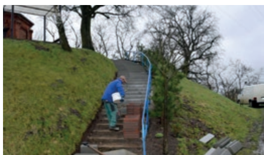
Remont schodów na wzgórzu św. Rocha
