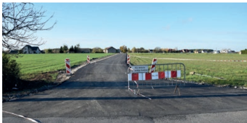
Wybudowano brakujący odcinek drogi pomiędzy Krobią a ul. Zielona Puszcza
