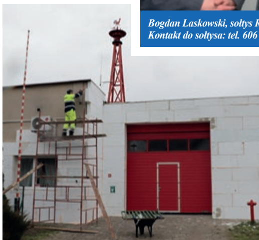
Budynek remizy i świetlicy przeszedł remont zewnętrzny wraz z termomodernizacją
