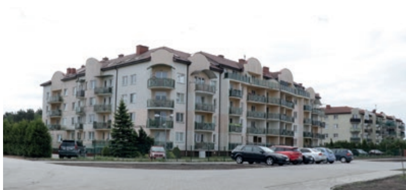
Zmodernizowano ul. Spółdzielczą wraz z nasadzeniami drzew i trawnikami
