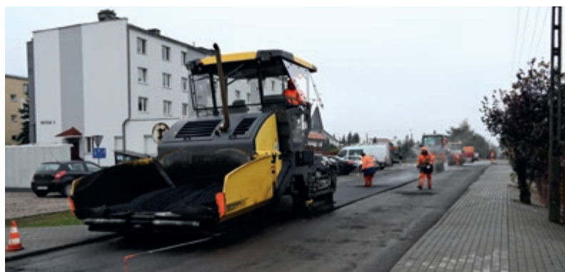
Ul. Piaskowa - jedna z głównych ulic Lubicza Górnego została kompletnie odnowiona, a na jej końcu pod kościołem powstała nowa pętla autobusowa
