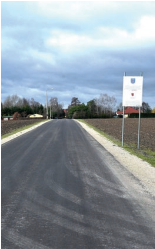
Wysafaltowano pierwszy odcinek drogi do Lipniczek i brakujący fragment drogi gminnej 733C
