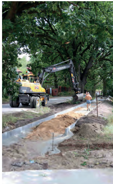
Budowa chodnika w Kopaninie. Fot. (RI)
