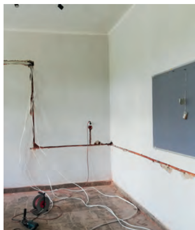
Modernizacja instalacji elektrycznej w świetlicy w Nowej Wsi
