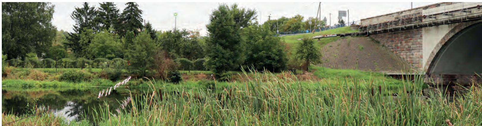
Przewiert pod dnem Drwęcy
