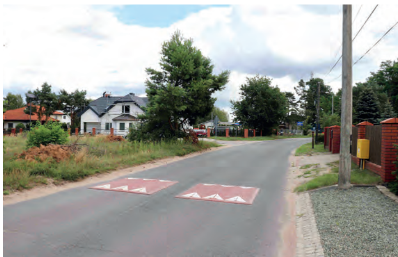
Spawalnicze wyspowe zostały zamontowane w Złotorii
