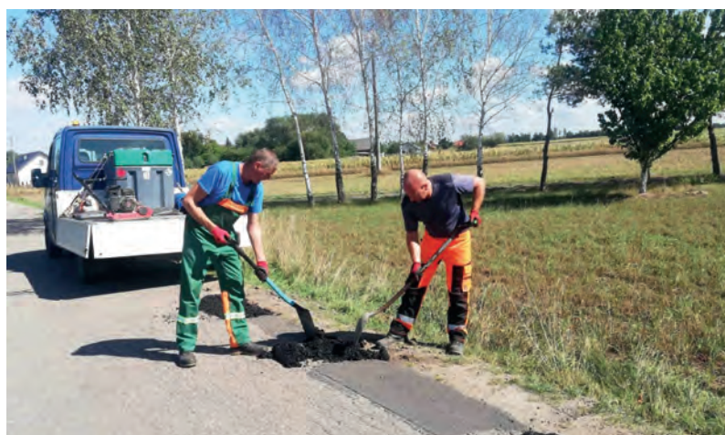
Łatanie dziur masą asfaltową na zimno na drogach gminnych
