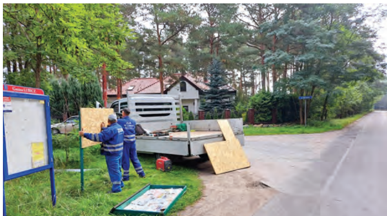
Montaż nowej tablicy ogłoszeń w Kopaninie
