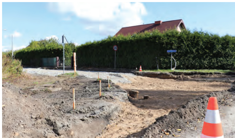
Przebudowa ul. Olszynowej w Krobi
