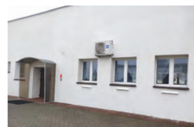
Nowe zadaszenie wejścia i ocieplona świetlica w Mierzynku
