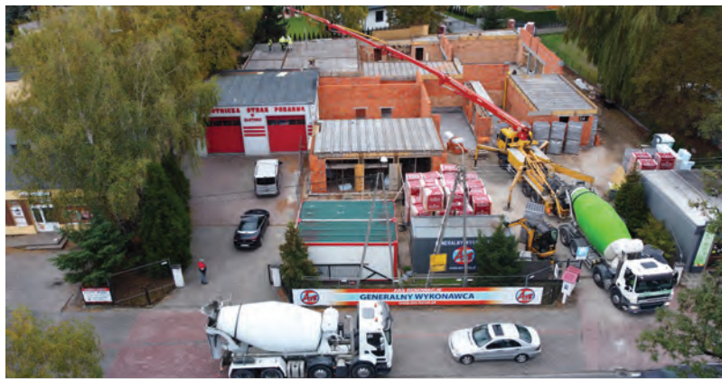
Tak z „lotu ptaka” budowa wyglądała pod koniec października. Fot. Nadesłane
