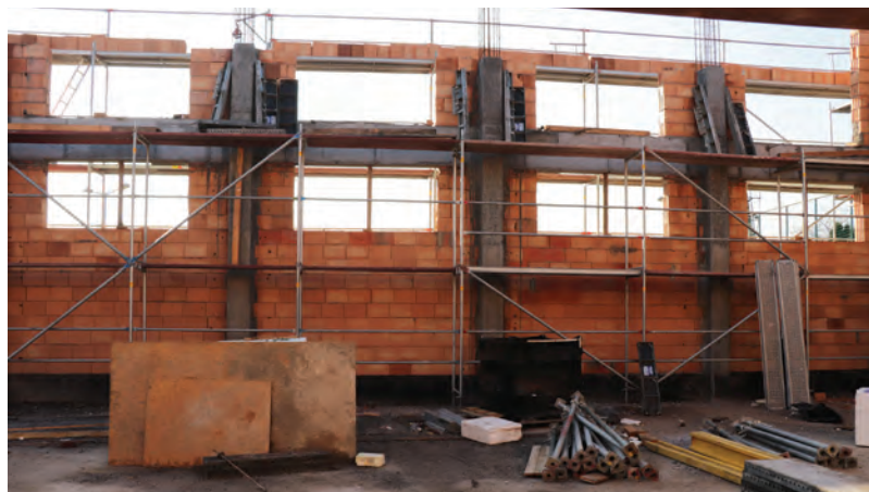
Budowa sali widziana od strony łącznika
