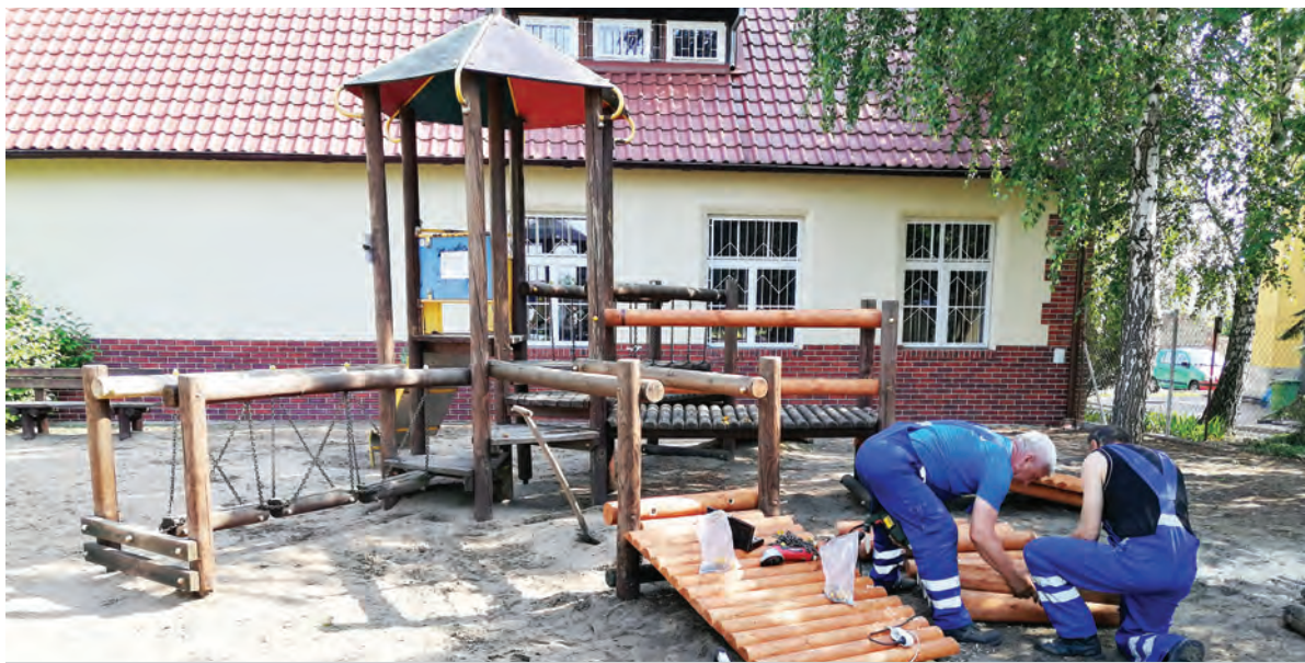
Fot. Marek Kwiatkowski Remont placu zabaw przy Szkole Podstawowej w Lubiczu Dolnym
