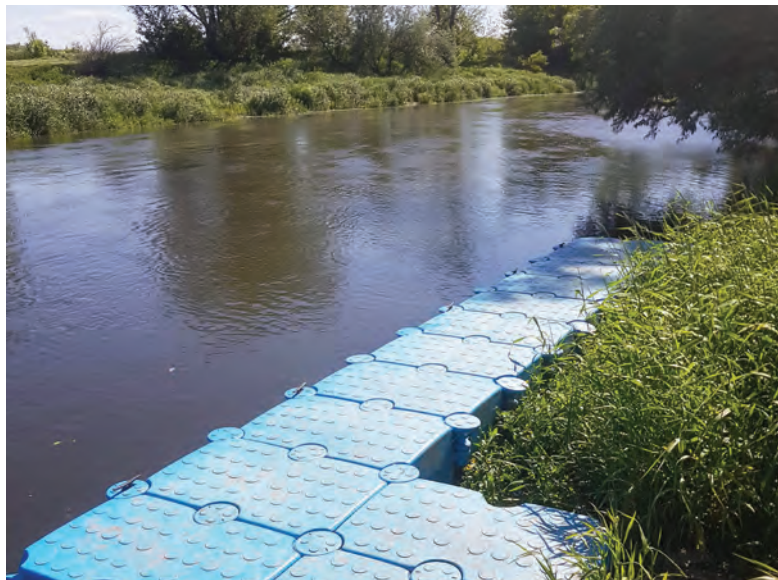
Fot. Damian Tarczykowski Taki pomost został zamontowany w Kaszczorku. Podobne będą także u nas
