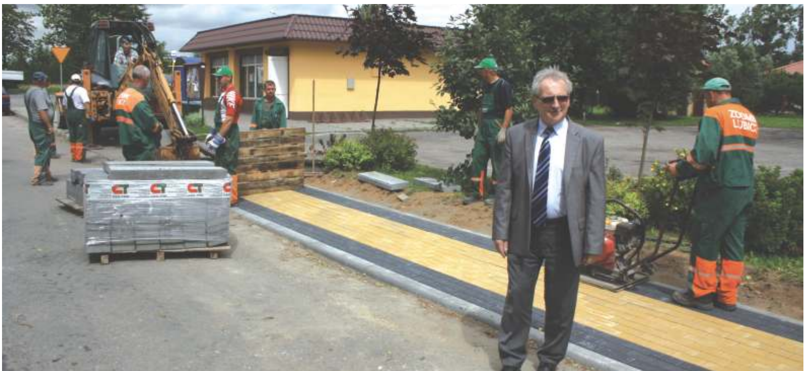
Wójt Marek Olszewski przy budowie chodnika w Gronowie
