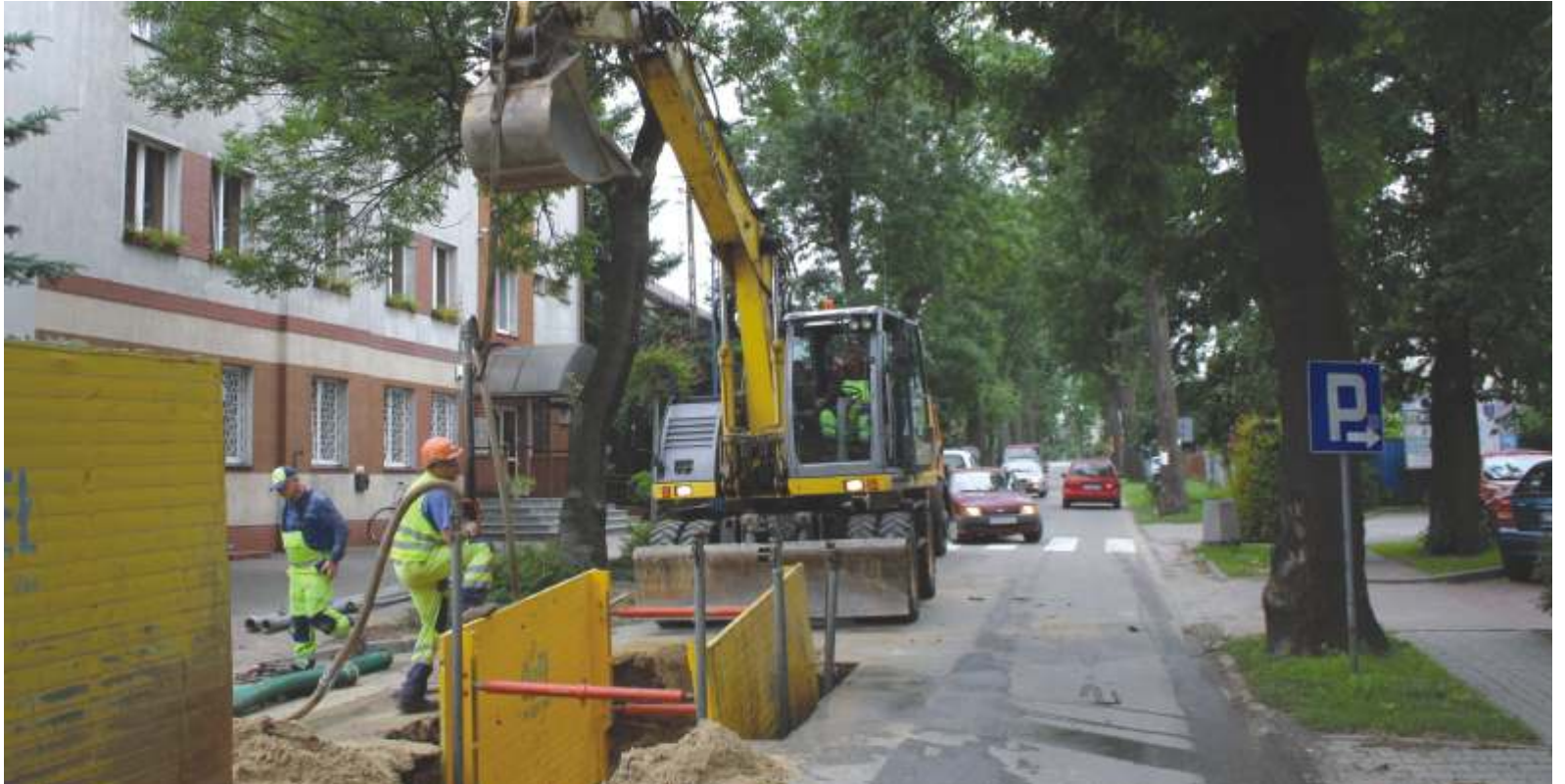
Prace w ulicy Toruńskiej w Lubiczu Dolnym
