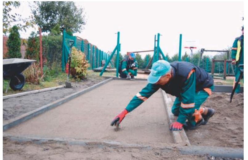
Robotnicy układają kostkę brukową na parkingu przy placu zabaw w Gronowie
