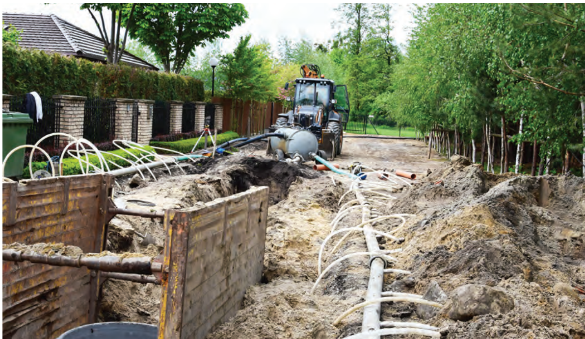
Fot. Z archiwum W tym roku gmina skanalizowała kilkanaście ulic w Krobi i Lubiczu Dolnym
